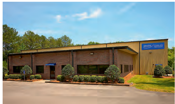
Brugg Cables LLC, Rome/GA, USA
